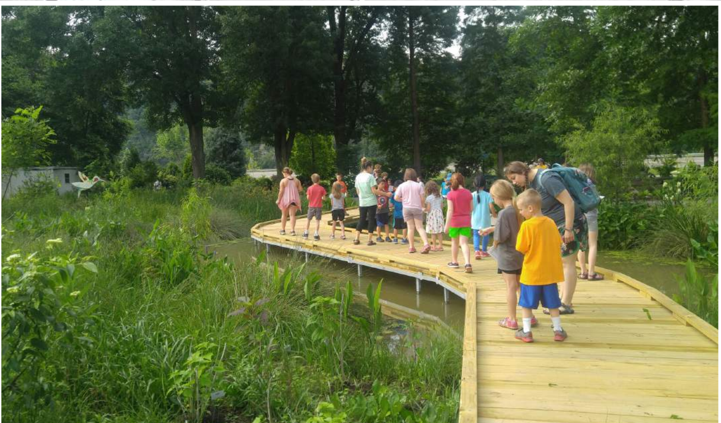
9 DECK BRIDGE | PUENTE DE MADERA
